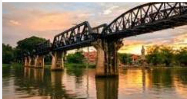
Γέφυρα Ποταμού Κβάι
