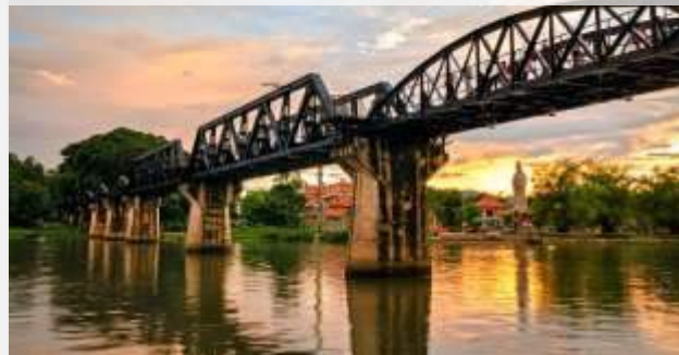
Γέφυρα Ποταμού Κβάι
